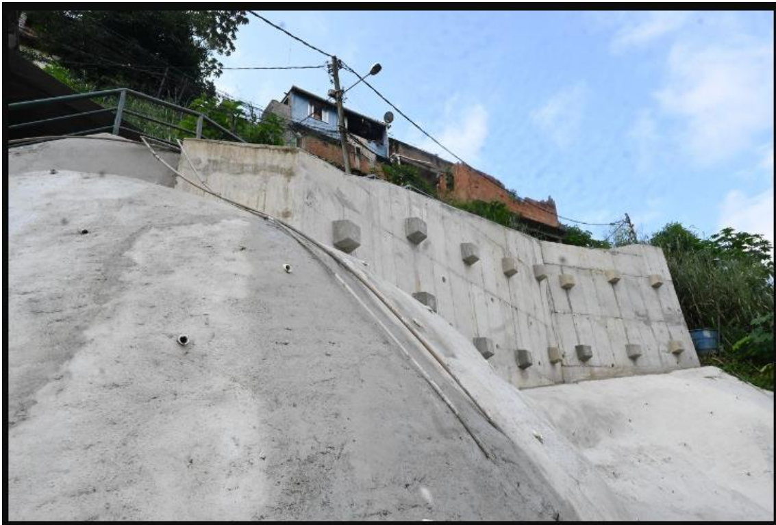
Figura 16 – Contenção de encosta em Viradouro
