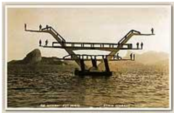
Figura 23 – Trampolim em concreto armado
