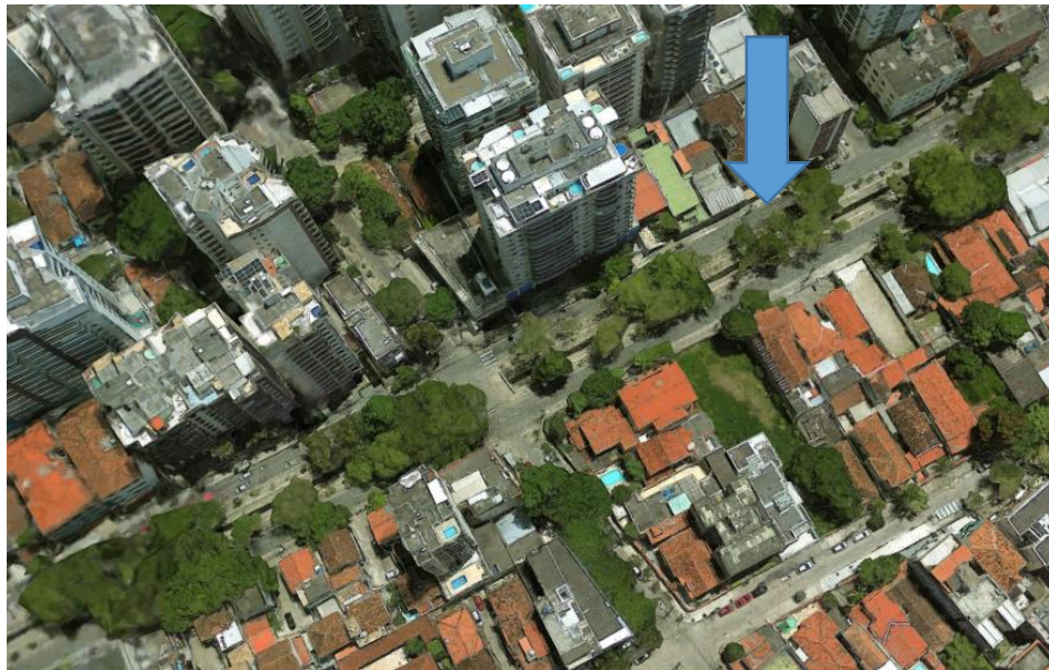
Figura 18 – Canal da Av. Ary Parreiras
